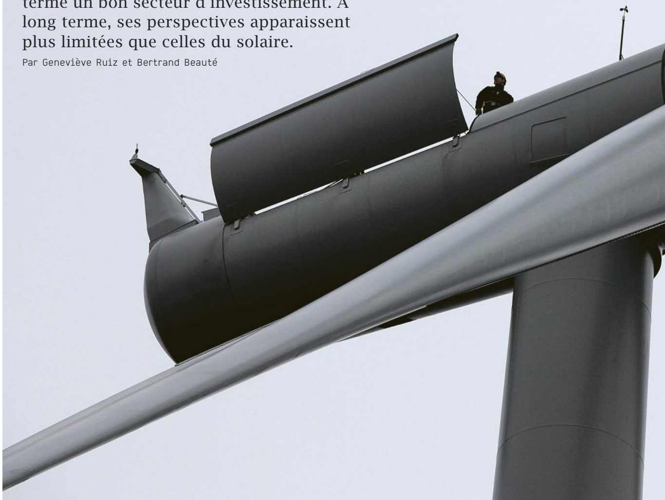
Maintenance d'une éolienne à Eaglesham Moor, près de Glasgow, en décembre 2009.
