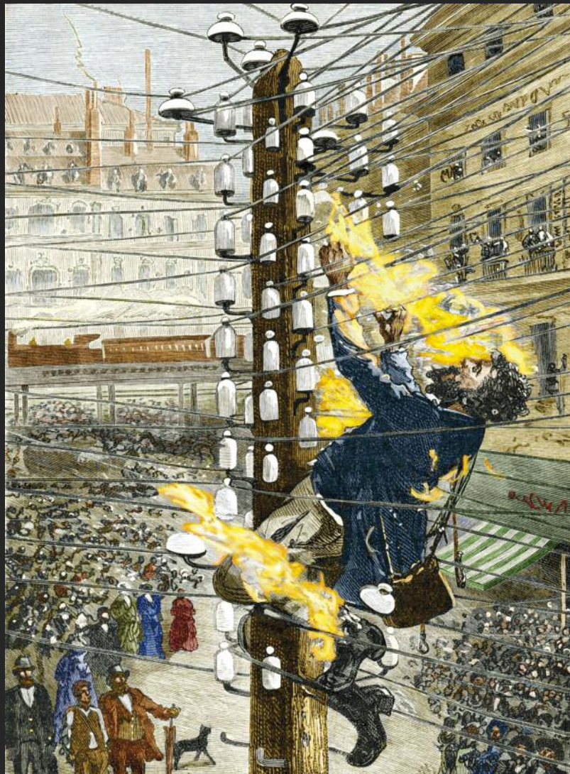
En 1889, John Feeks, un employé de la Western Union, est électrocuté alors qu'il répare des lignes de courant alternatif.
